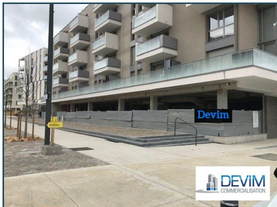
Photo vue ensemble (côté parc)
